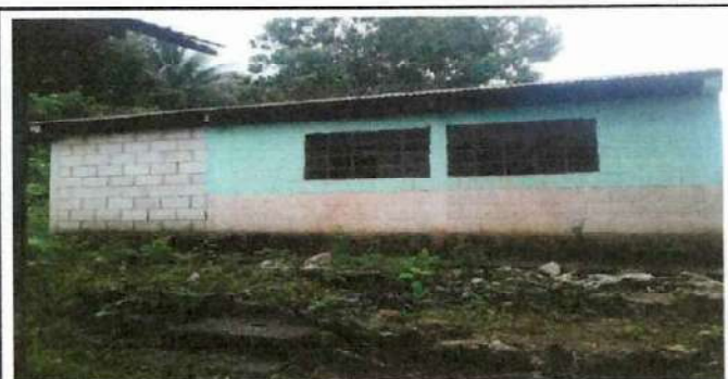
Foto 6: Mantenimiento de muros interiores y exteriores
