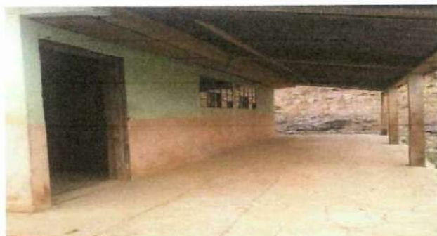
Foto 3: Sustitución de piso concreto.
