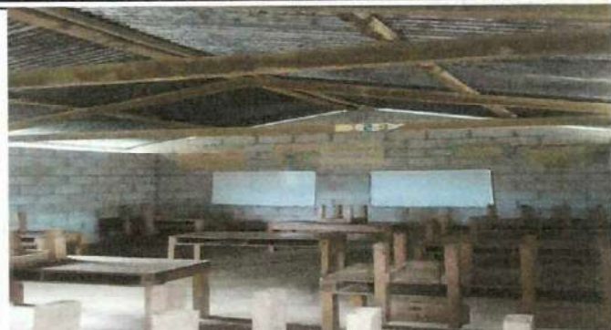
Foto 2: Sustitución de estructura de techo.
