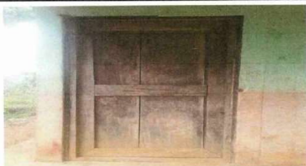
Foto 5: Sustitución de puerta del aula.
