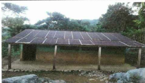
Foto 1: Sustitución de cubierta de lámina.
