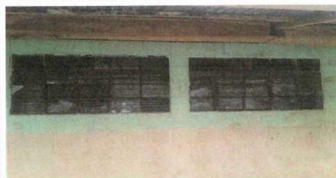
Foto 4: Mantenimiento de ventana y colocación de vidrio.
